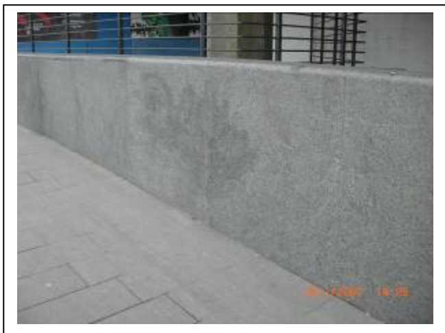
Figur 2.1: Granitmur hvor man kan se tydelige spor efter fjernelse af graffiti.
